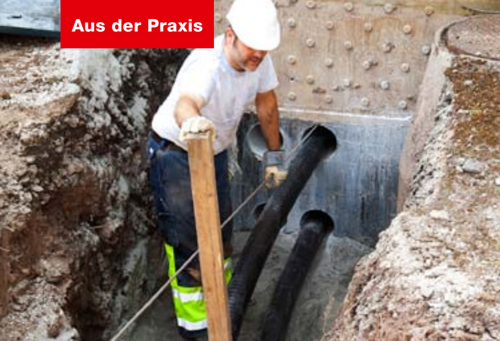
Grosses Engagement: Die Montage wird vom Leiter Verkauf & Engineering der Brugg Rohrsystem Schweiz persönlich durchgeführt.
